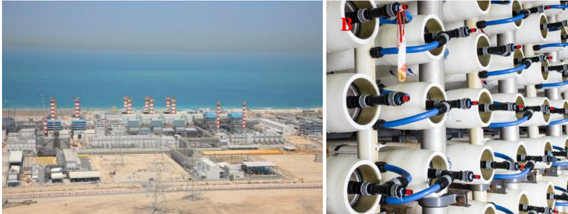
Figura 1 – Exemplos de usinas de dessalinização de água (a) Planta localizada em Dubai com capacidade de produzir mais de 2 bilhões de litros d'água por dia. (b) Sequenciamento de membranas de osmose reversa da usina de Ashkelon, Israel.
